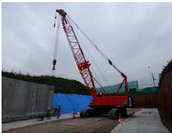
プレキャスト擁壁施工状況
